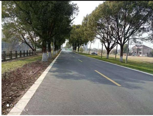
图 4-1 一般农地勘察现场图一
