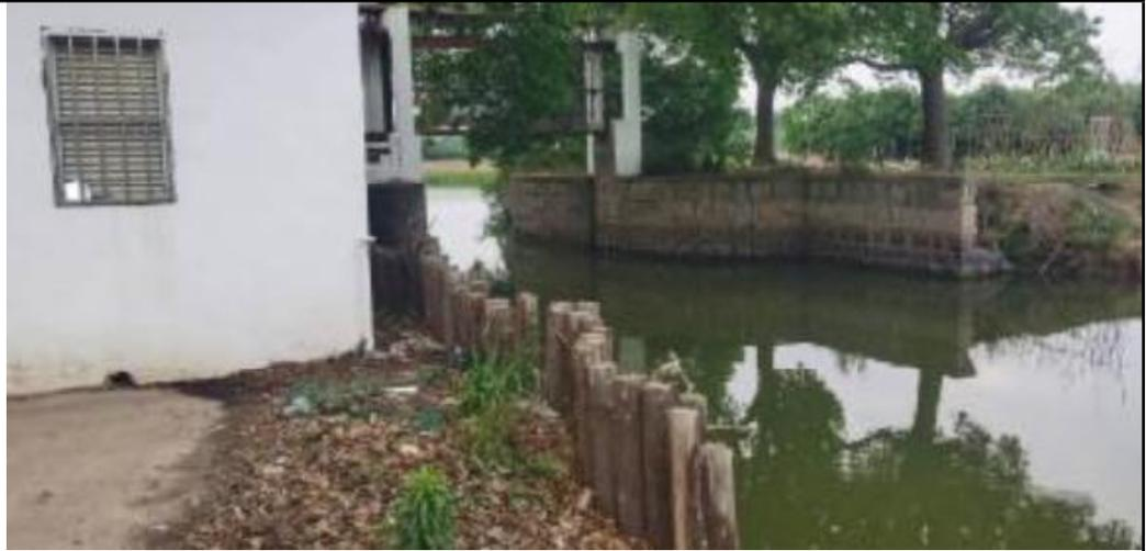
④吉山中心河段：现状为土质岸坡，部分硬质驳岸；沿线杂草丛生，岸坡参差不齐，河底淤积严重。
