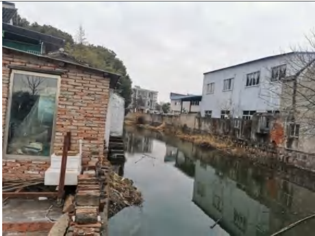
陈巷村人家江：常年未清淤，淤积严重，岸线杂乱，景观较差。本项目进行河道疏浚，局部浚深（包括南侧新开 54m 河道，河宽 15m）。
