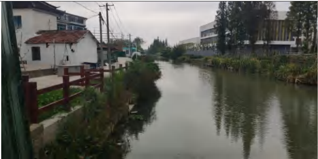
团结河：水质感官较差，河岸杂乱。本项目进行新增木桩驳岸、穿孔曝气、挺水植物带、水下森林、清淤清杂和水面垃圾收集器 2 套。
