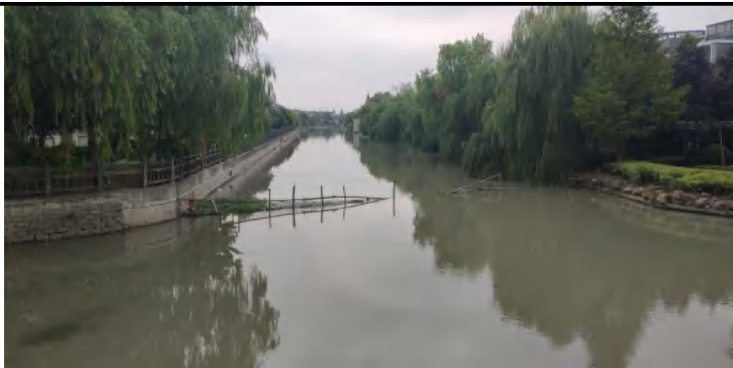
沅渡泾：水质感官较差，河岸杂乱。本项目进行植物种植平台、微孔曝气系统 3 套、喷泉曝气 2 套、排口生态拦截带、生态浮床。
