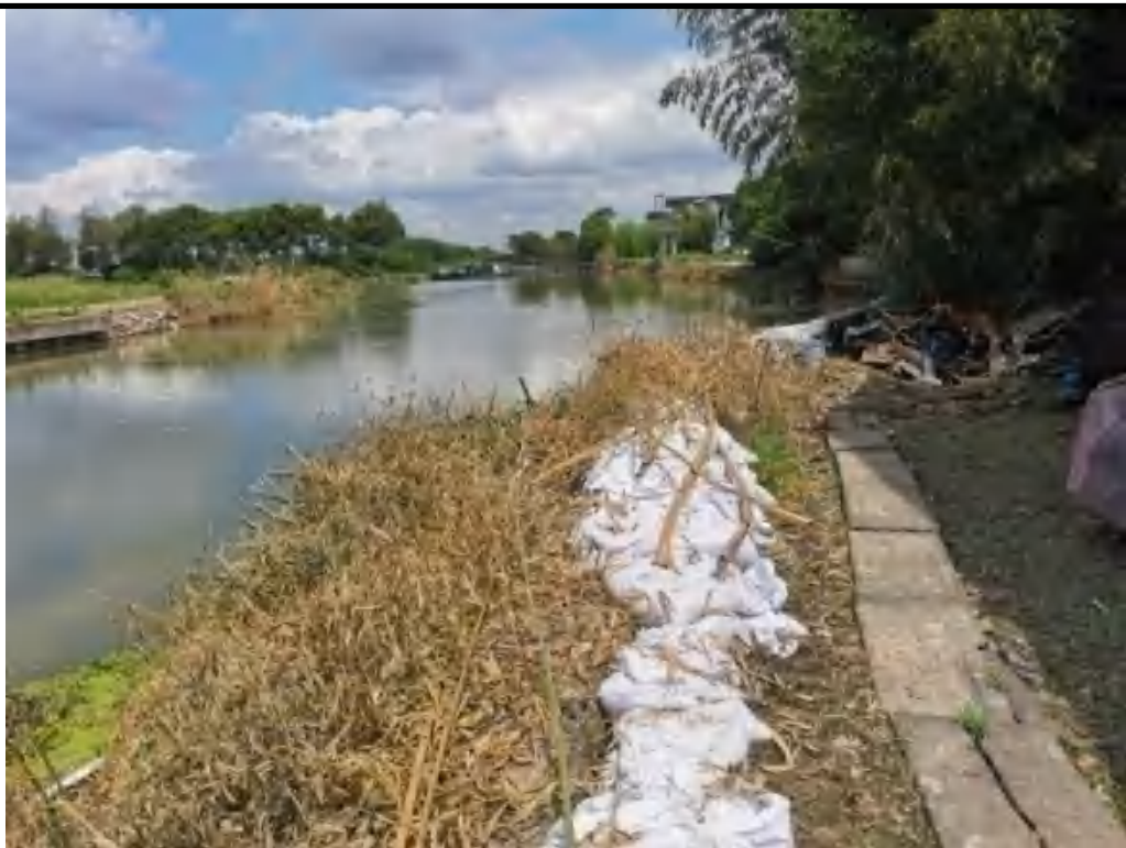
汤灯港：岸线杂乱，景观较差。本项目进行新建防洪墙、新建河埠。
