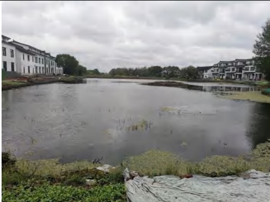
白龙潭：常年未清淤，淤积严重，岸线杂乱，景观较差。本项目进行清淤疏浚、边坡修整、新建圆木桩护岸。
