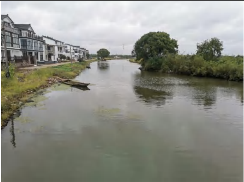
南汤灯港：河道常年未清淤，淤积严重，河岸杂乱，局部冲刷严重。本项目对河道河道清淤疏浚、边坡修整、新建圆木桩护岸。
