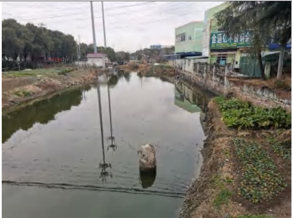
朱家山河：常年未清淤，淤积严重，河岸杂乱，局部冲刷严重。本项目进行河道疏浚，总局部浚深，管道连通朱家山路两侧河道。
