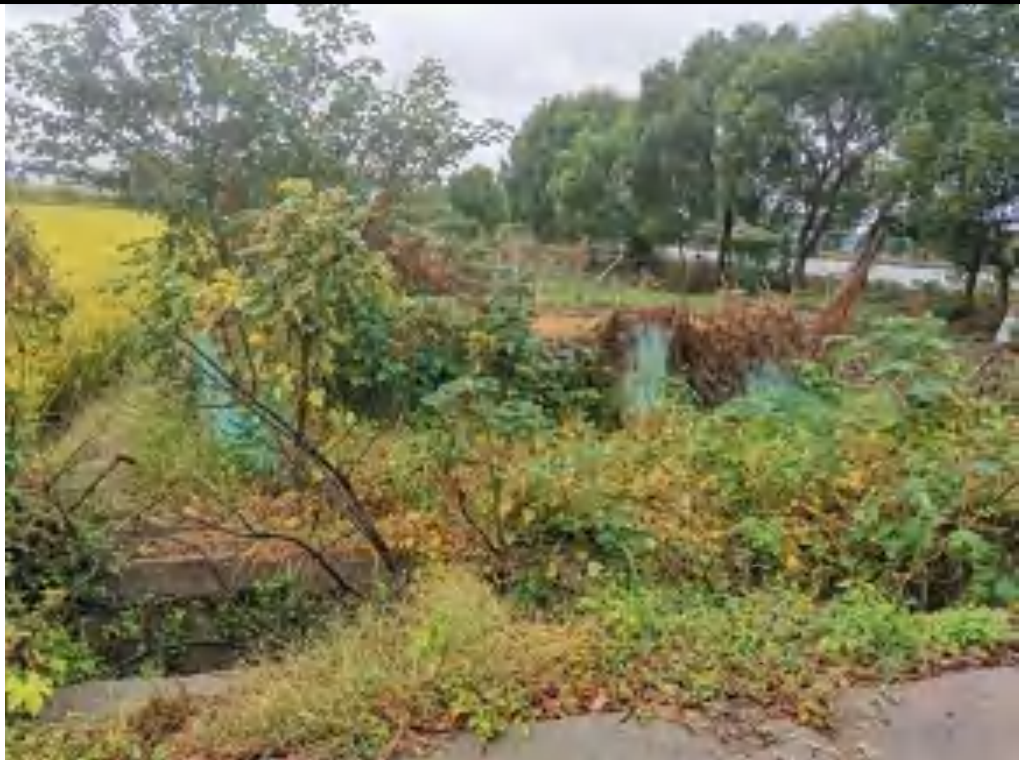
曲巷港：150m 河道被填埋，水系不畅。本项目对东段河道疏浚，总长 190m；西段河道整治（新开）150m；新建桥涵。
