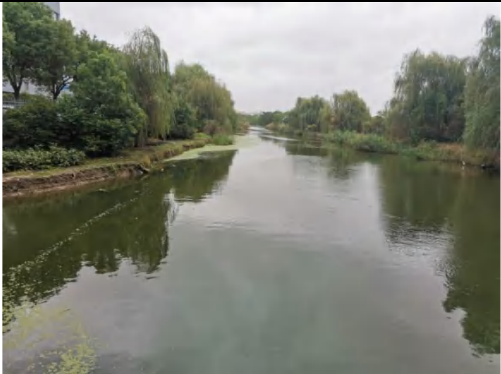
韩科河：常年未清淤，淤积严重，河岸杂乱，局部冲刷严重。本项目进行河道疏浚，局部浚深，季广路两侧新建生态护岸。
