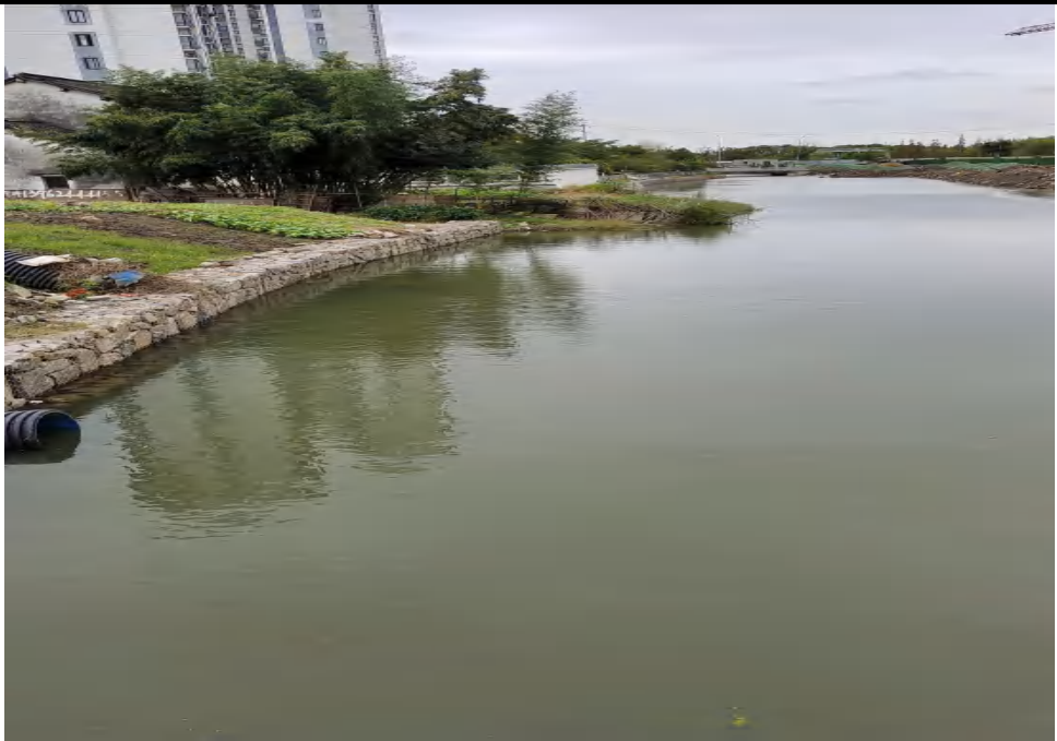
培庄港：水质感官不佳。本项目进行直接生态工程措施（控源截污工程、水循环景观、面源污染拦截、生态修复）。
