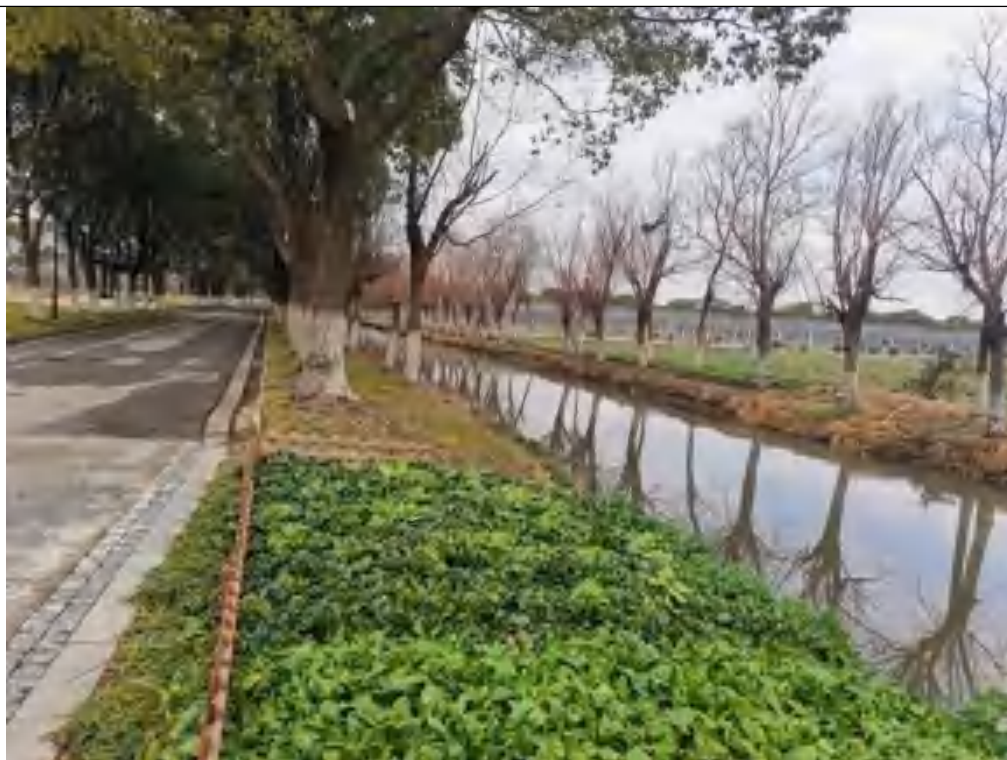
吴桥浜：常年未清淤，淤积严重，河岸杂乱，局部冲刷严重。本项目进行河道疏浚，两侧新建圆木桩护岸。
