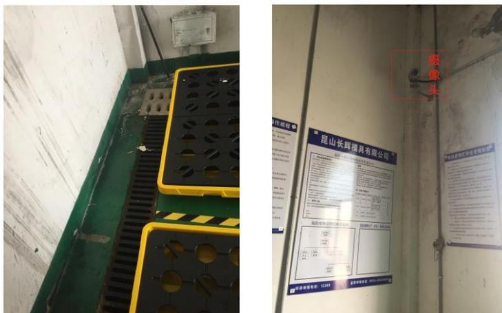
危废堆场内部导流沟、导流槽及摄像头
