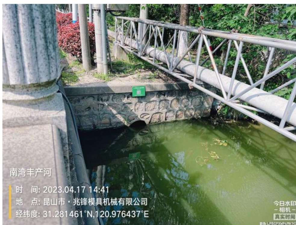
园区雨水管网排口
