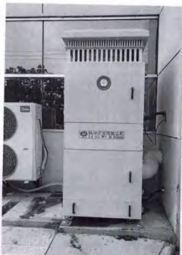
图 4.2-4 脉冲式滤筒集尘机
