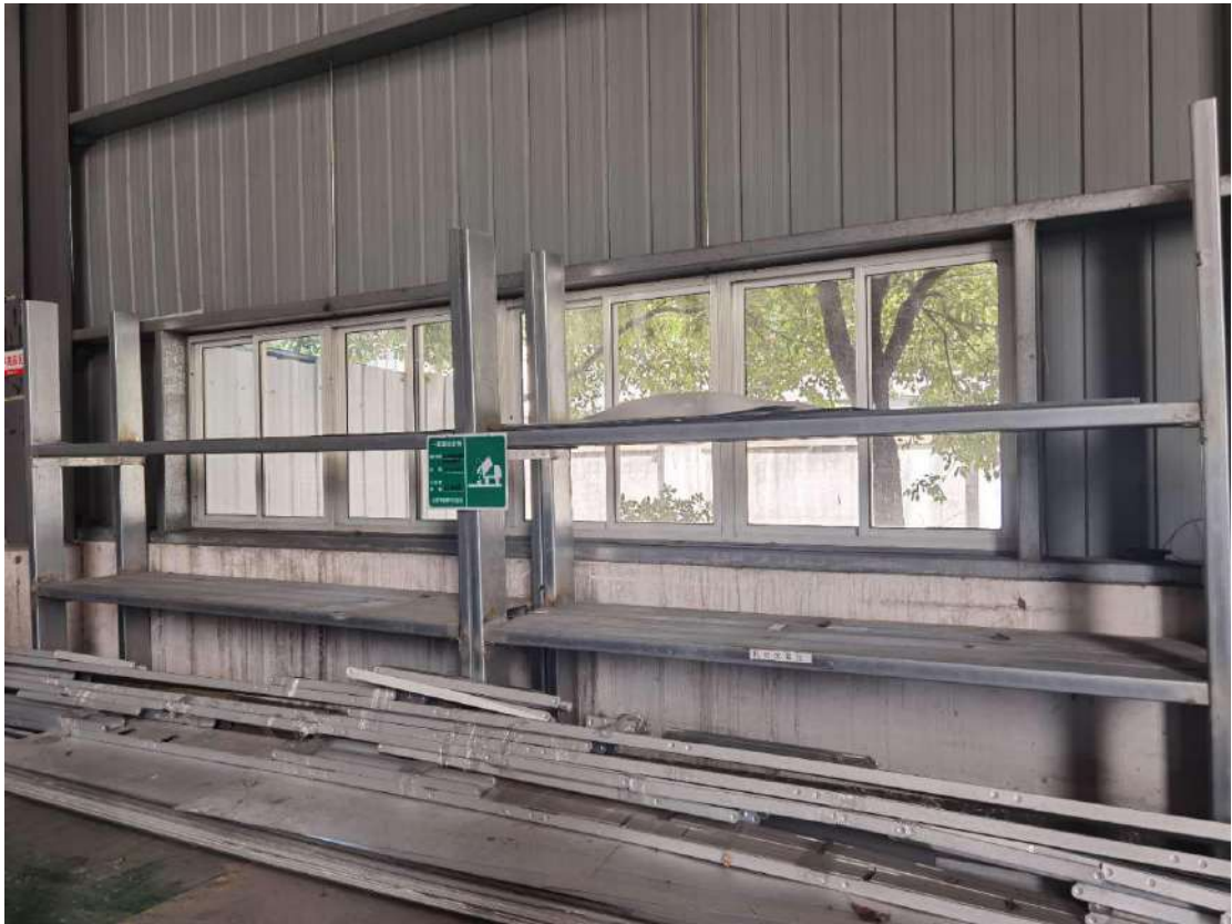
图 4-1 一般固废贮存设施
