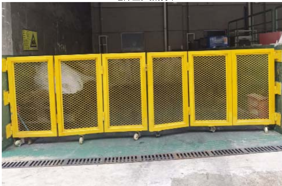
防泄漏导流沟
