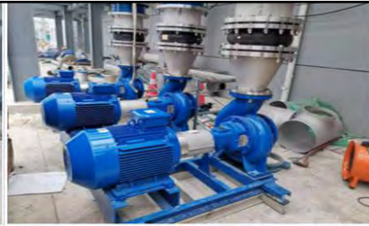
曝气循环泵安装完成
