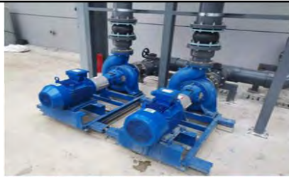
缺氧循环泵安装完成
