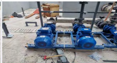
清洗泵安装完成
