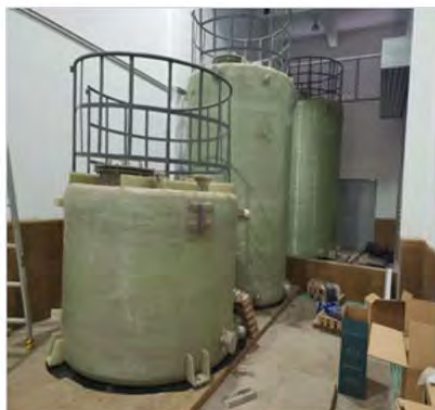
化学品桶槽安装定位
