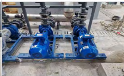
RO输送泵安装完成
