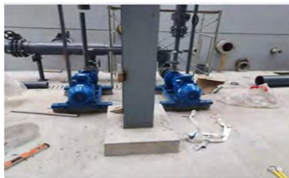
RO原水泵安装完成
