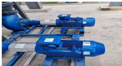
原水泵安装完成
