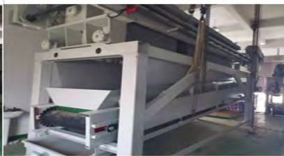
污泥脱水机安装完成
