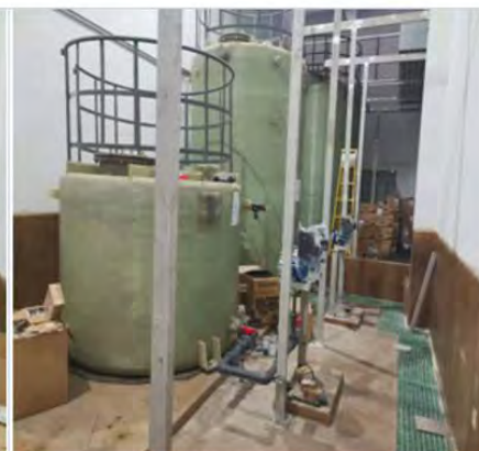
化学管道管架安装
