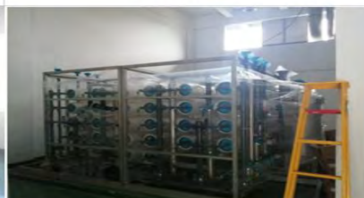
RO机组安装完成
