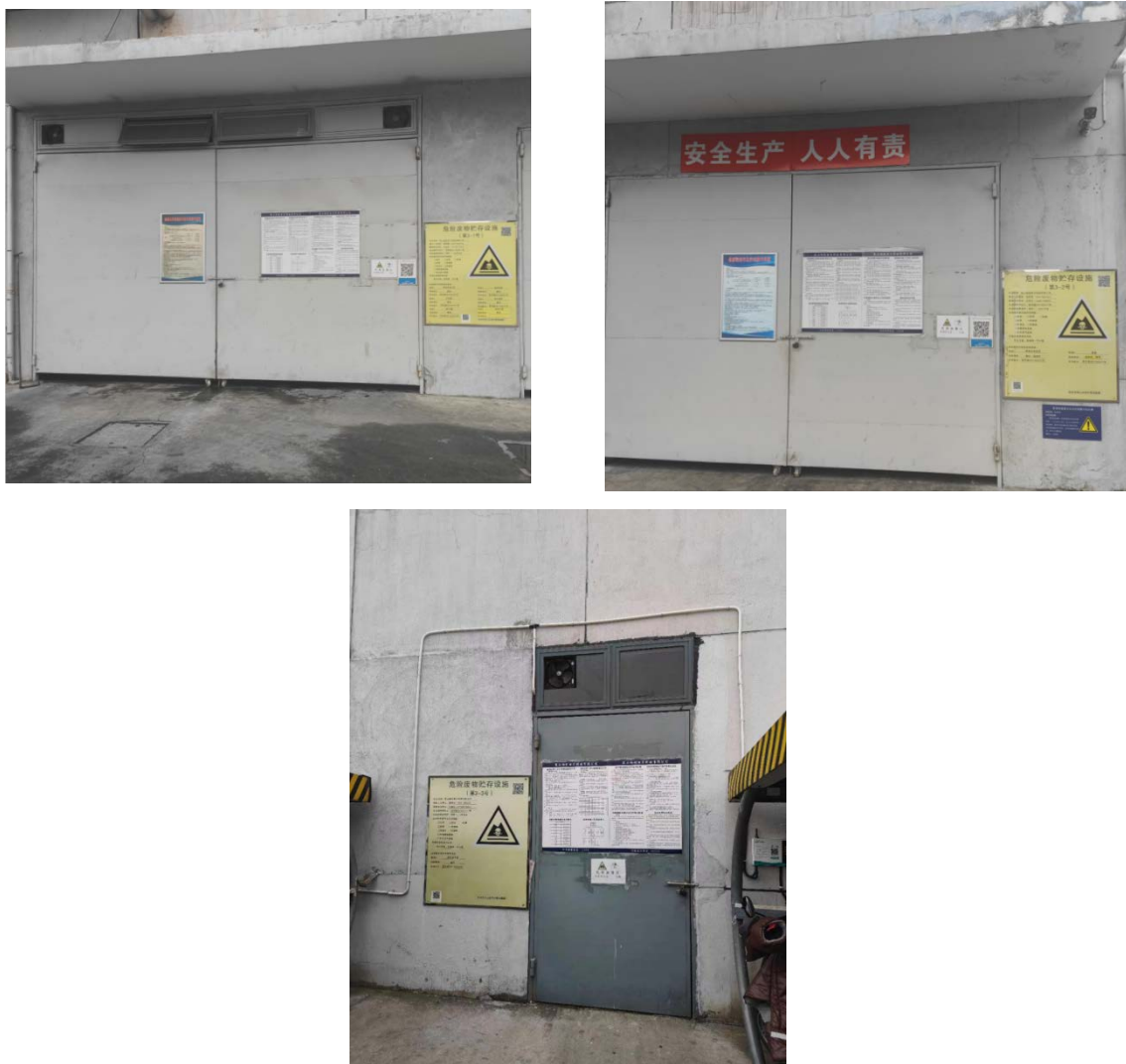
图 3.1.7-9 现有危废暂存间
