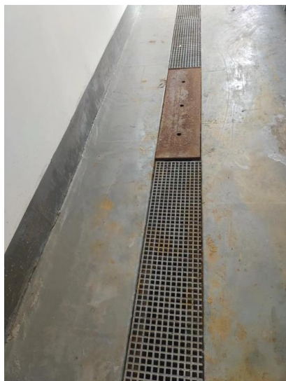
危废仓库设置收集池及导流沟槽
